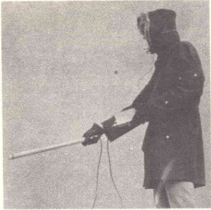
Fig. 2 - Apparecchio «Piep» a lunga portata per squadre di soccorso.
